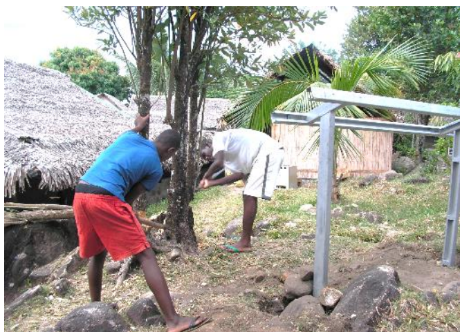
Installation du support des panneaux solaires
