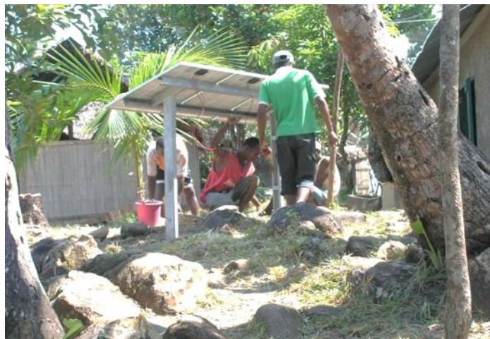
Préparation du béton pour sceller le support
